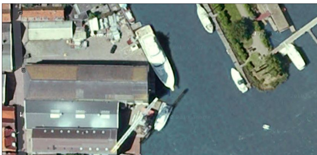
Afbeelding 2: Luchtfoto van het plangebied. Rechtsboven is de havendam zichtbaar (bron: Google Maps).
